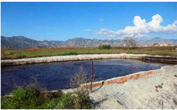
Fig 1. Bacini di evaporazione delle acque di vegetazione
