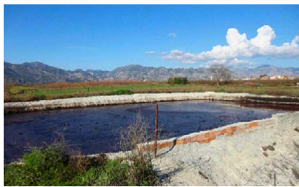
Figure 1 : Bassins d'évaporation des margines.
